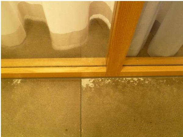
*Aufsteigende Feuchtigkeit aus der Fuge eines nicht vollständig verlegereifen Fliesestrichs.*
