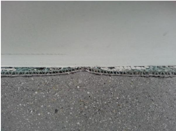
*Verheerend: Randstreifen mit Heftklammern befestigt. Das wird Risse geben! (siehe Empfehlung PAV-E 20-2014 «Randstreifen bei Estrichen»)*
